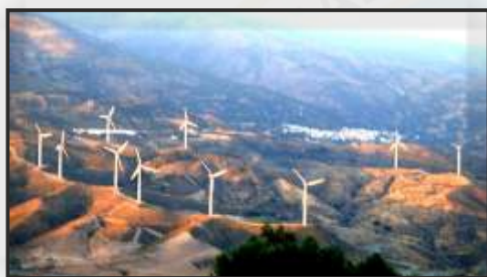
Figura 2. Parque Eólico en Lanjaron (Granada) España. Los aerogeneradores se instalan en la cresta de las lomas.
